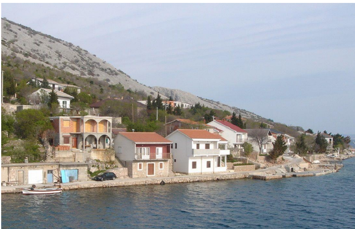
Slika 2.2-7 Pogled na dio luke na kojem je planirana rekonstrukcija.
